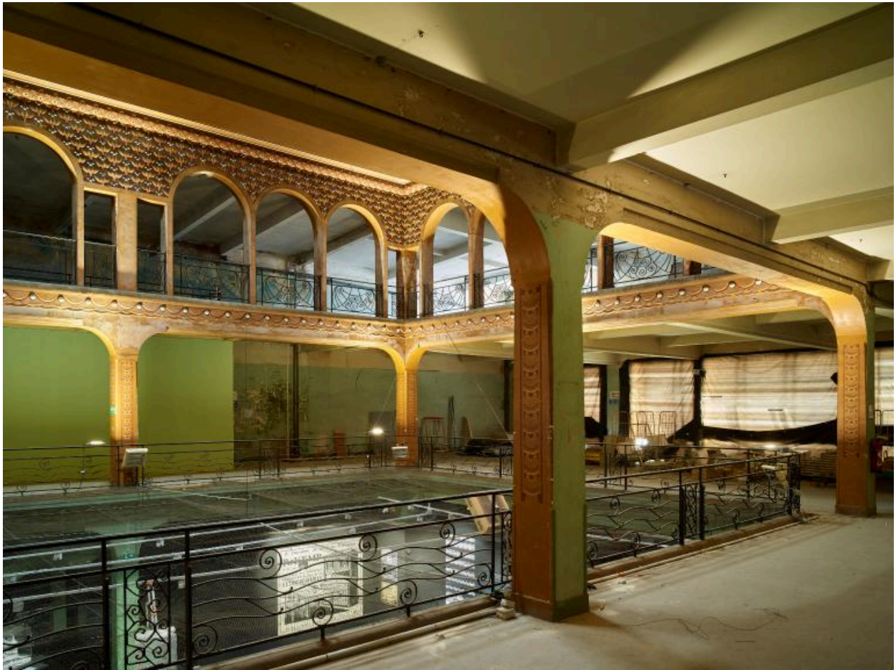
Ensemble intérieur de l'atrium rectangulaire, vue du premier étage.
