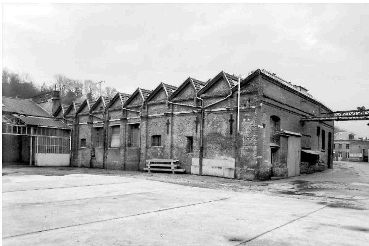
Atelier de réparation mécanique.
