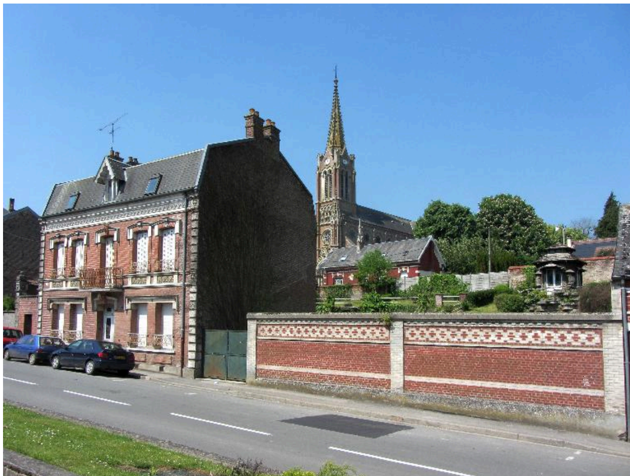
Vue d'ensemble sur rue.
