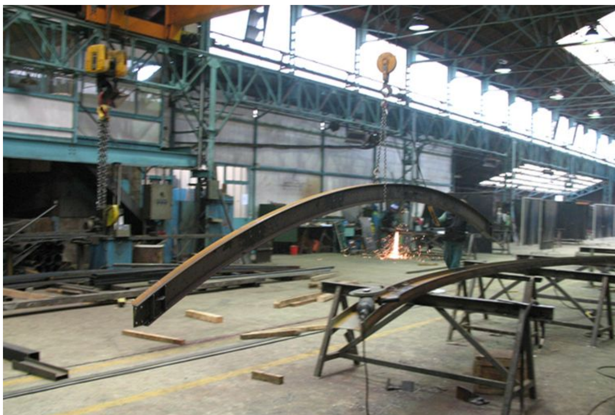
Poutrelle métallique dirigée vers l'atelier de peinture.
