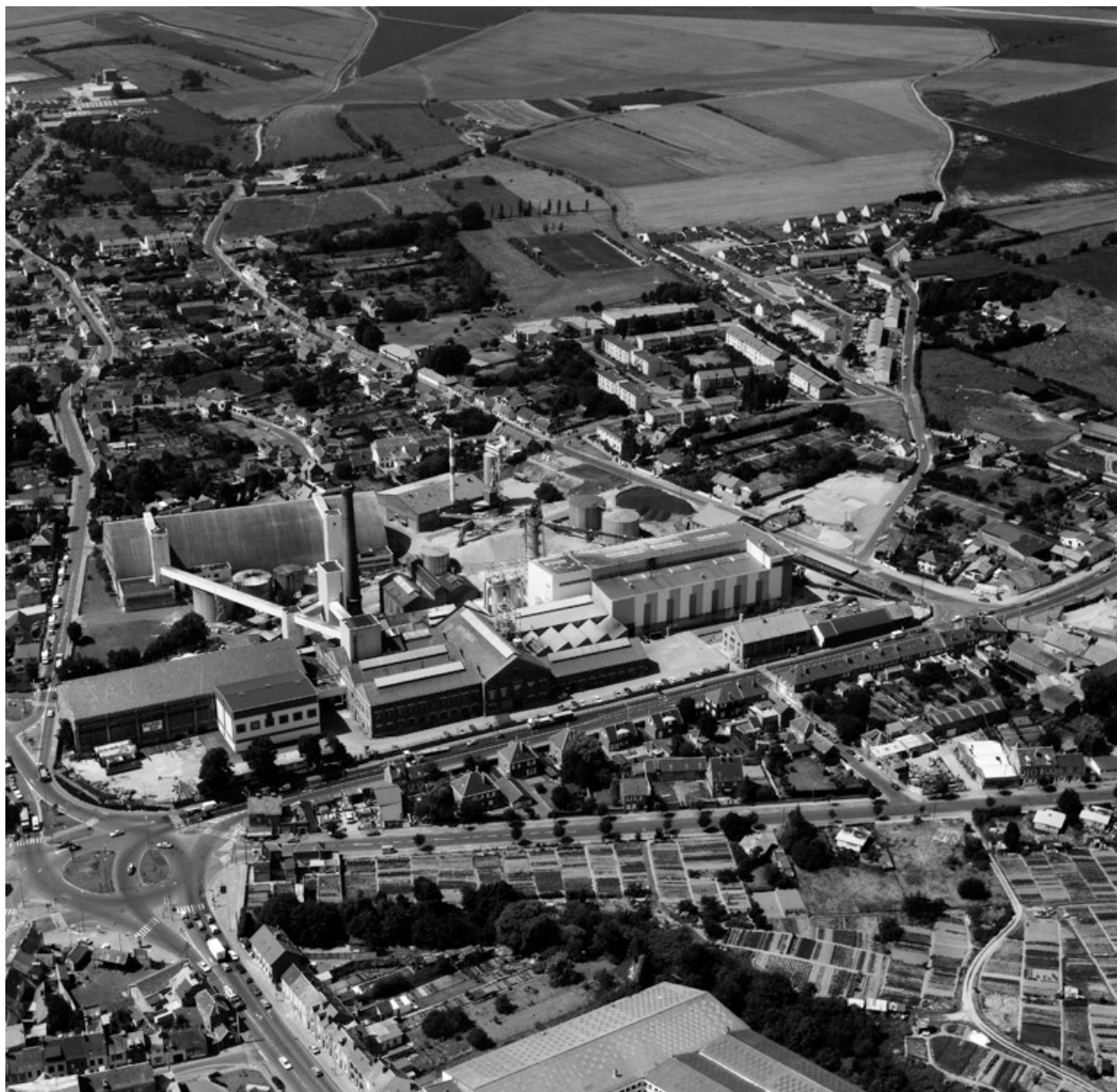
Vue aérienne de 1990, flanc est.
