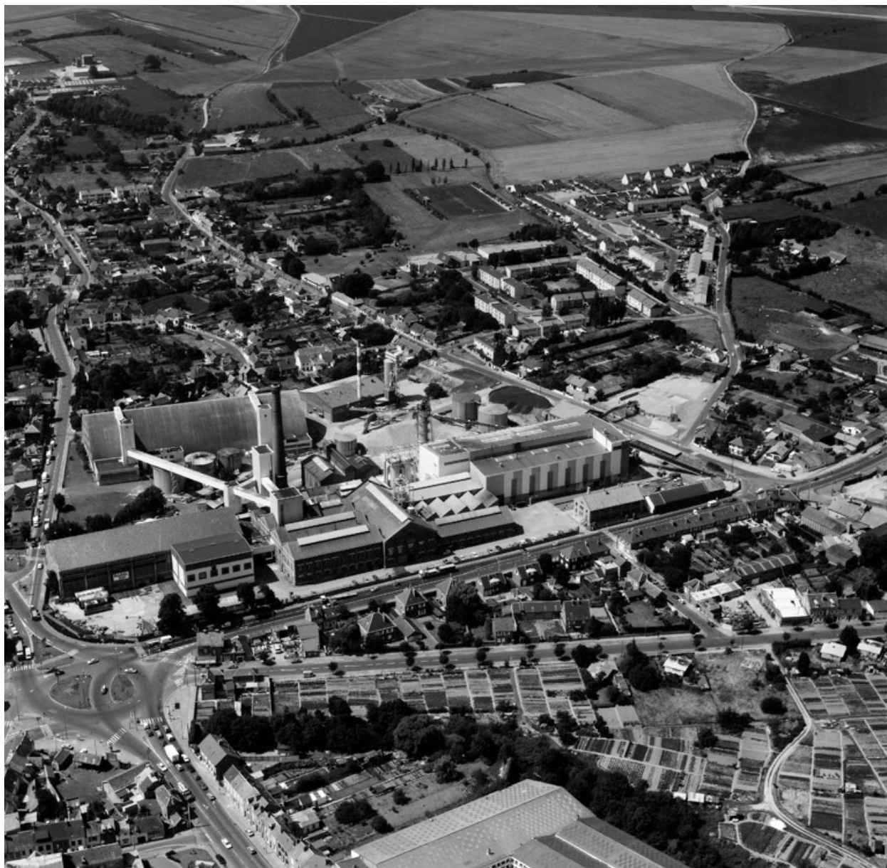
Vue aérienne de 1990, flanc est.
