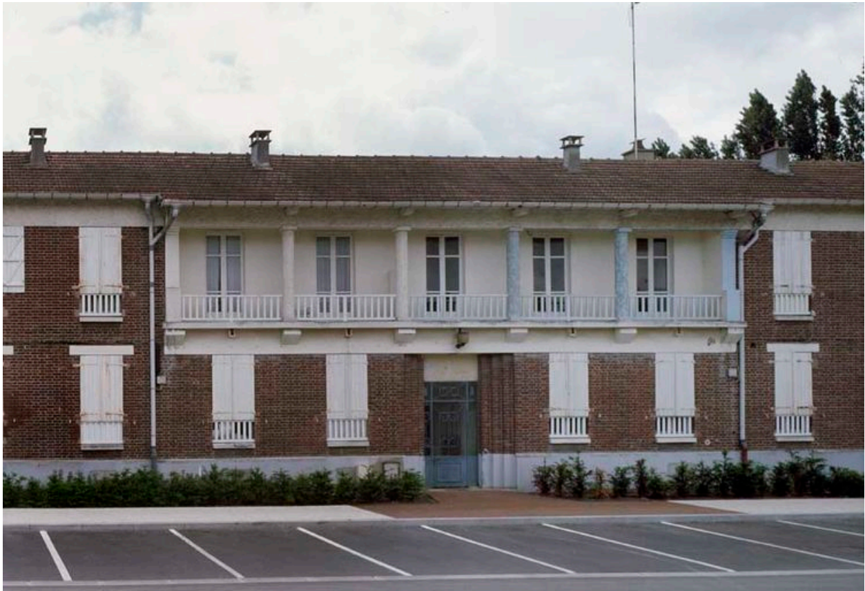
Bâtiment 520 : Entrée des logements et détail de la colonnade.
