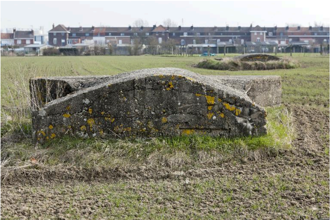
Vue vers le nord-est. D'avant en arrière : casemates a et b
