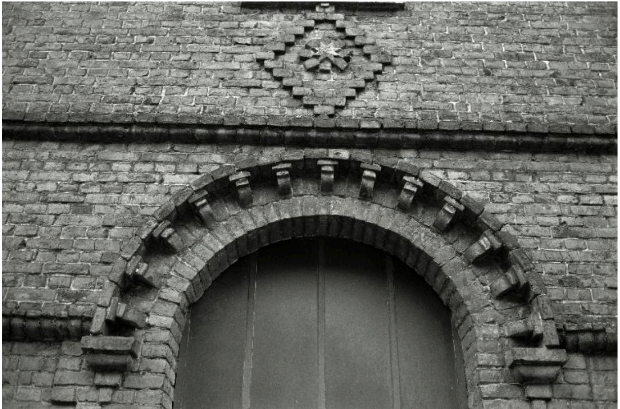
Détail d'une baie de l'atelier de fabrication, en 1990.
