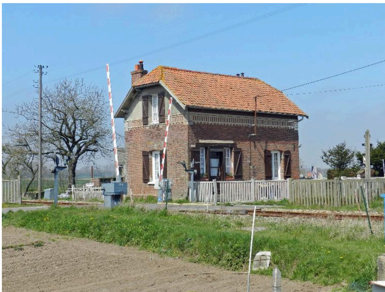
Maison de garde-barrière, rue Camille-Pelletan.
