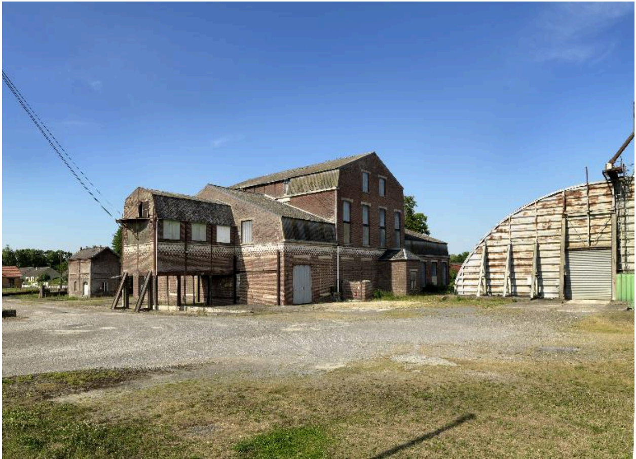
Vue d'ensemble nord-ouest de la râperie.
