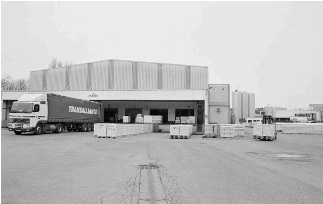
Quai de chargement des palettes de lait UHT.
