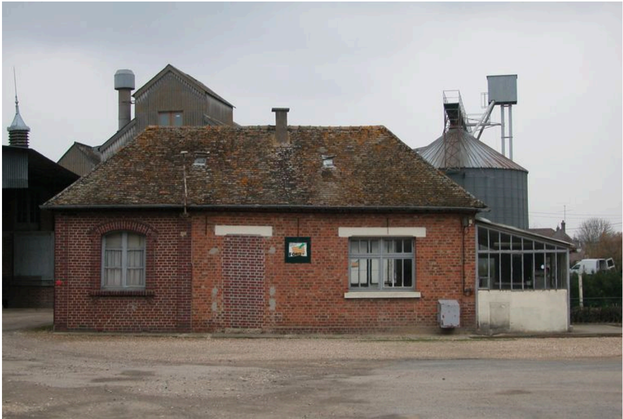
Le bureau, façade sur cour.
