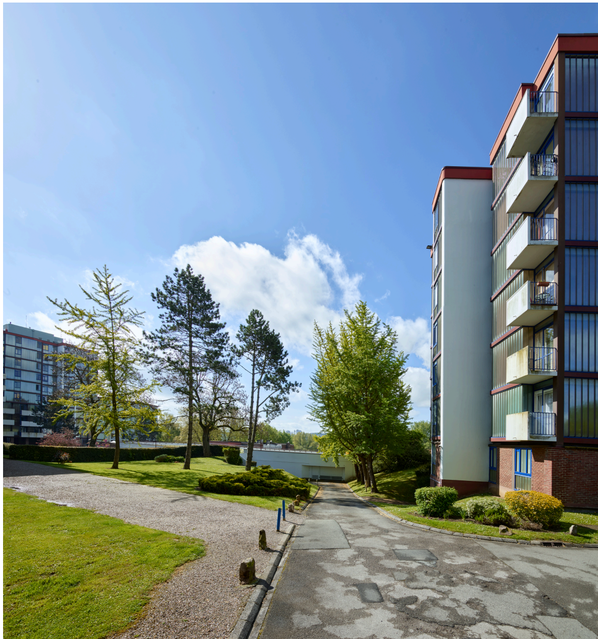
Entrée des garages, vue depuis l'accès véhicules de la rue François Genin.
