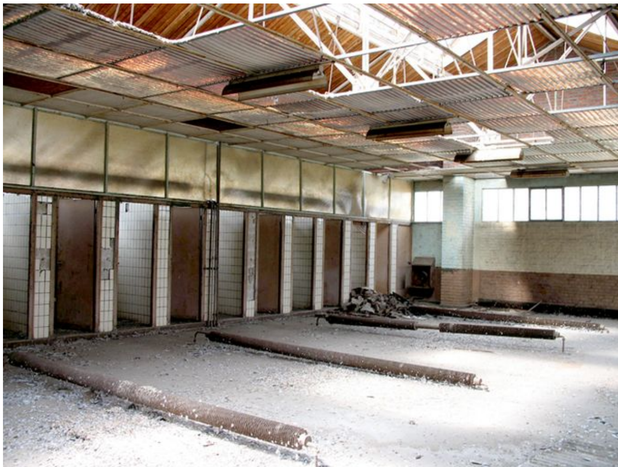
Ancien vestiaire avec au fond les douches.
