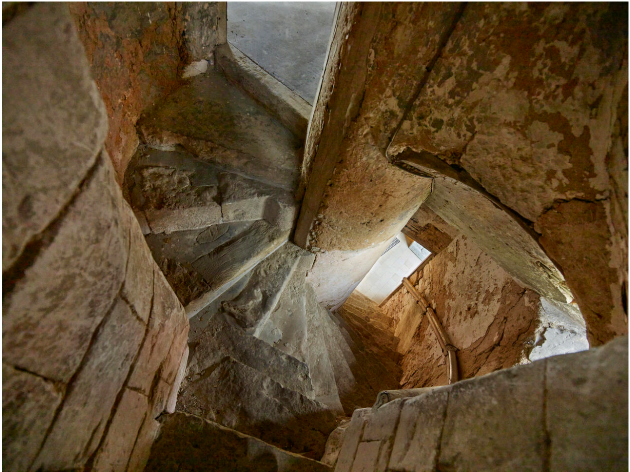
Escalier en vis logé dans l'une des tourelles du beffroi.
