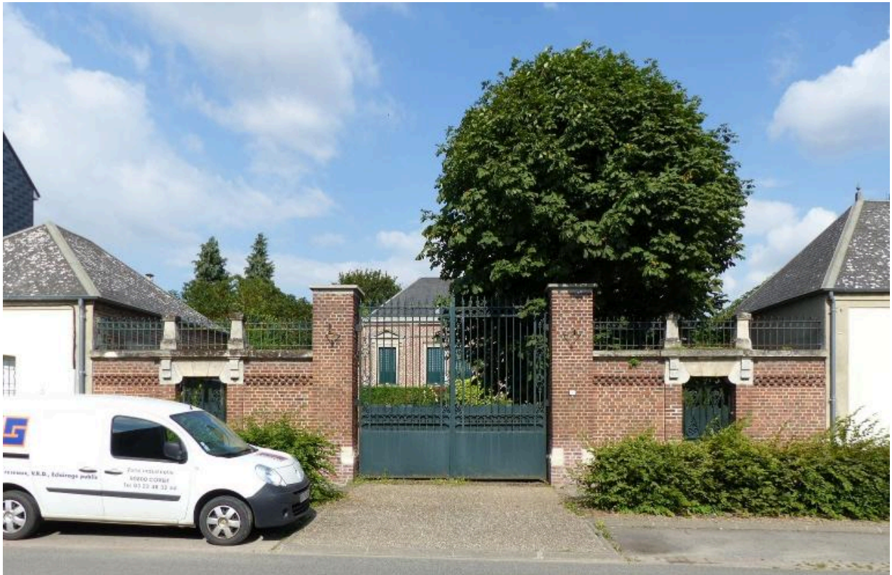
Vue de situation depuis la rue.
