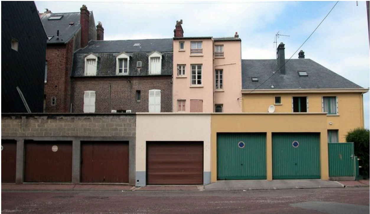
Ensemble de garages, 6 à 10 rue Henri-Leboeuf.
