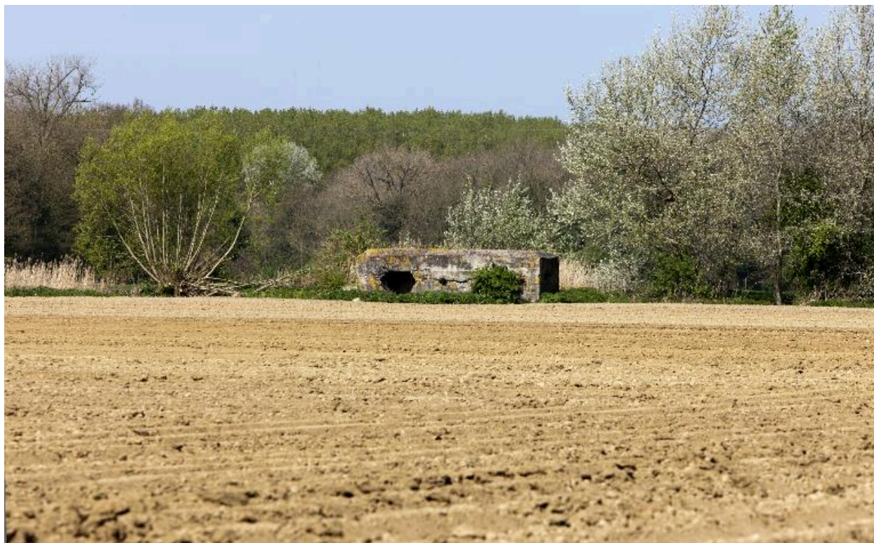
Vue générale vers le nord-ouest
