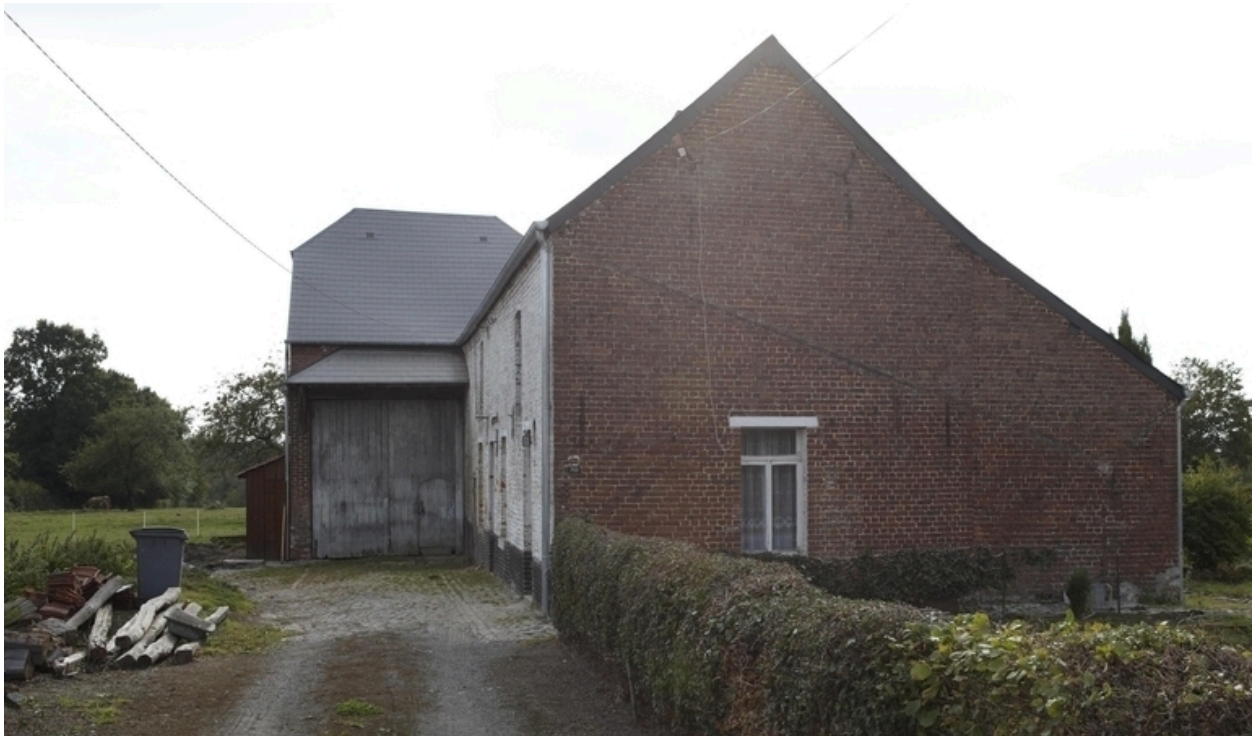
Vue de l'élévation est et de la grange située au sud.
