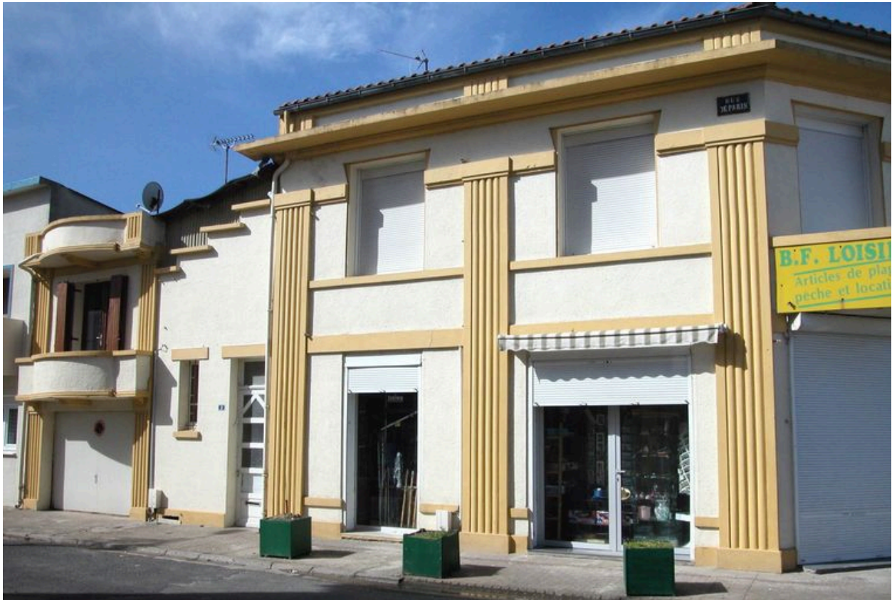
Elévation sur la rue de Paris.
