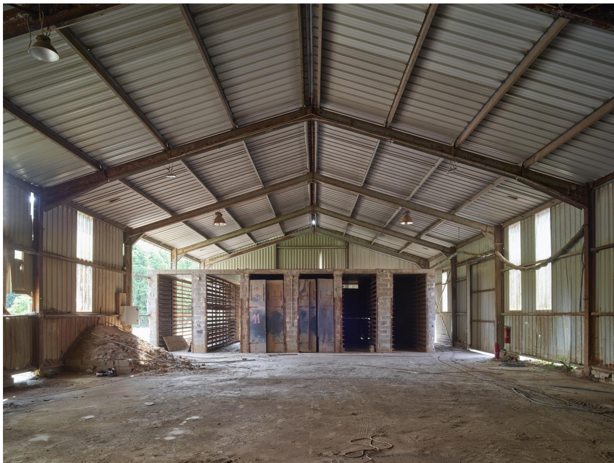
Hangar des séchoirs (étuves). Vue intérieure en long prise vers l'est.
