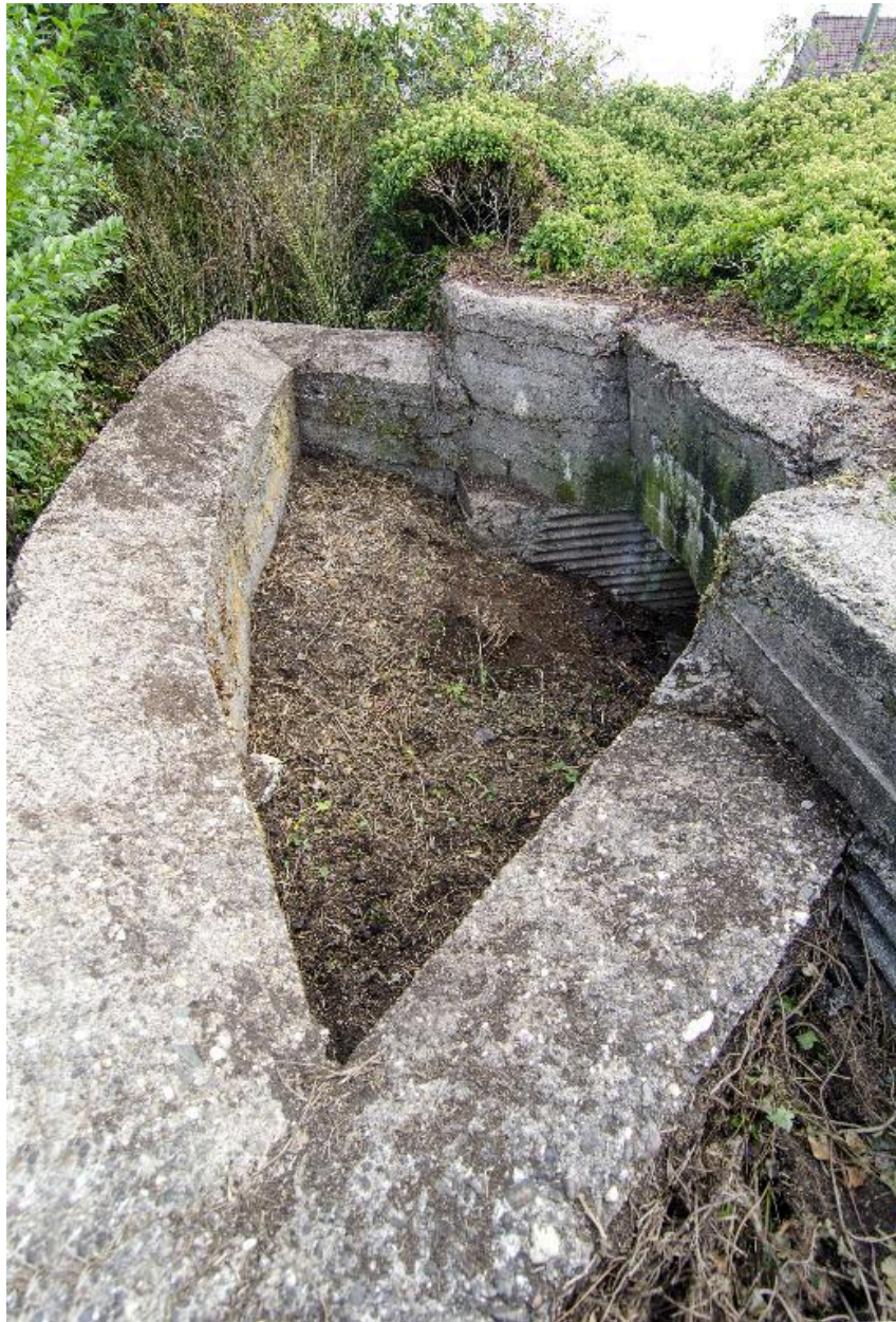
Elévation nord, la cuve à canon (au grand angle)
