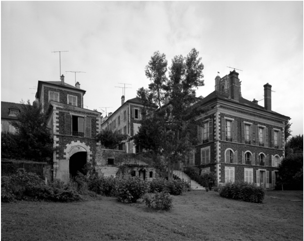
Vue du pavillon en meulière sur le jardin avec les terrasses et les escaliers.
