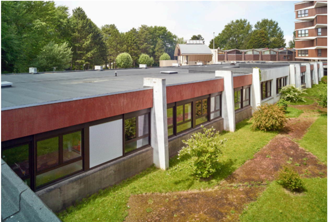
Vue de trois quarts de l'élévation est du C.E.T., depuis la toiture du C.E.T. fermant le patio.
