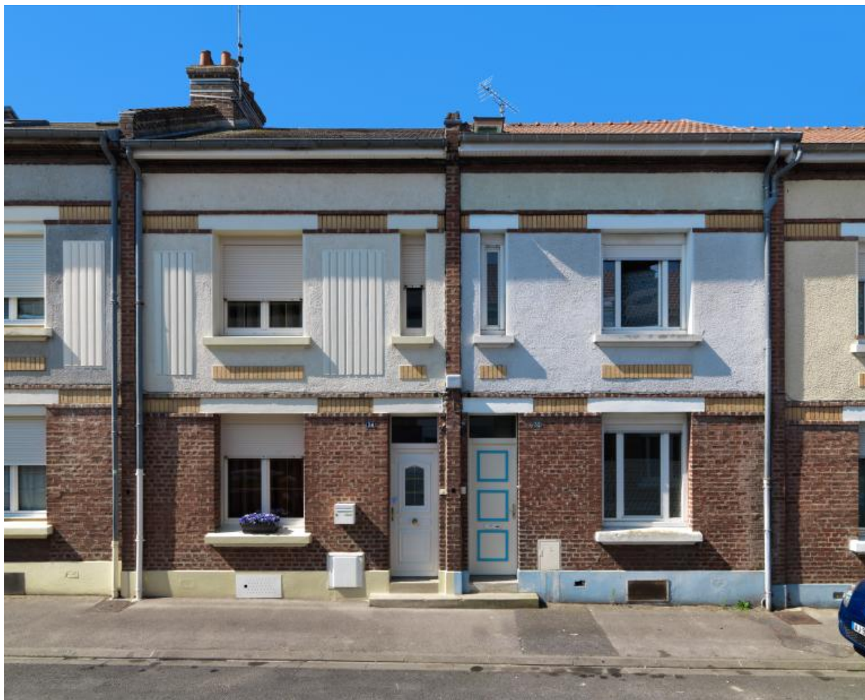
Vue de deux logements.
