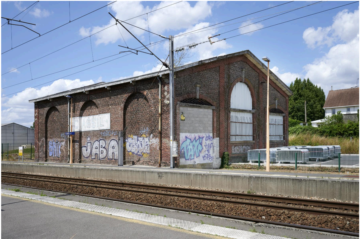
Vue générale depuis les voies.
