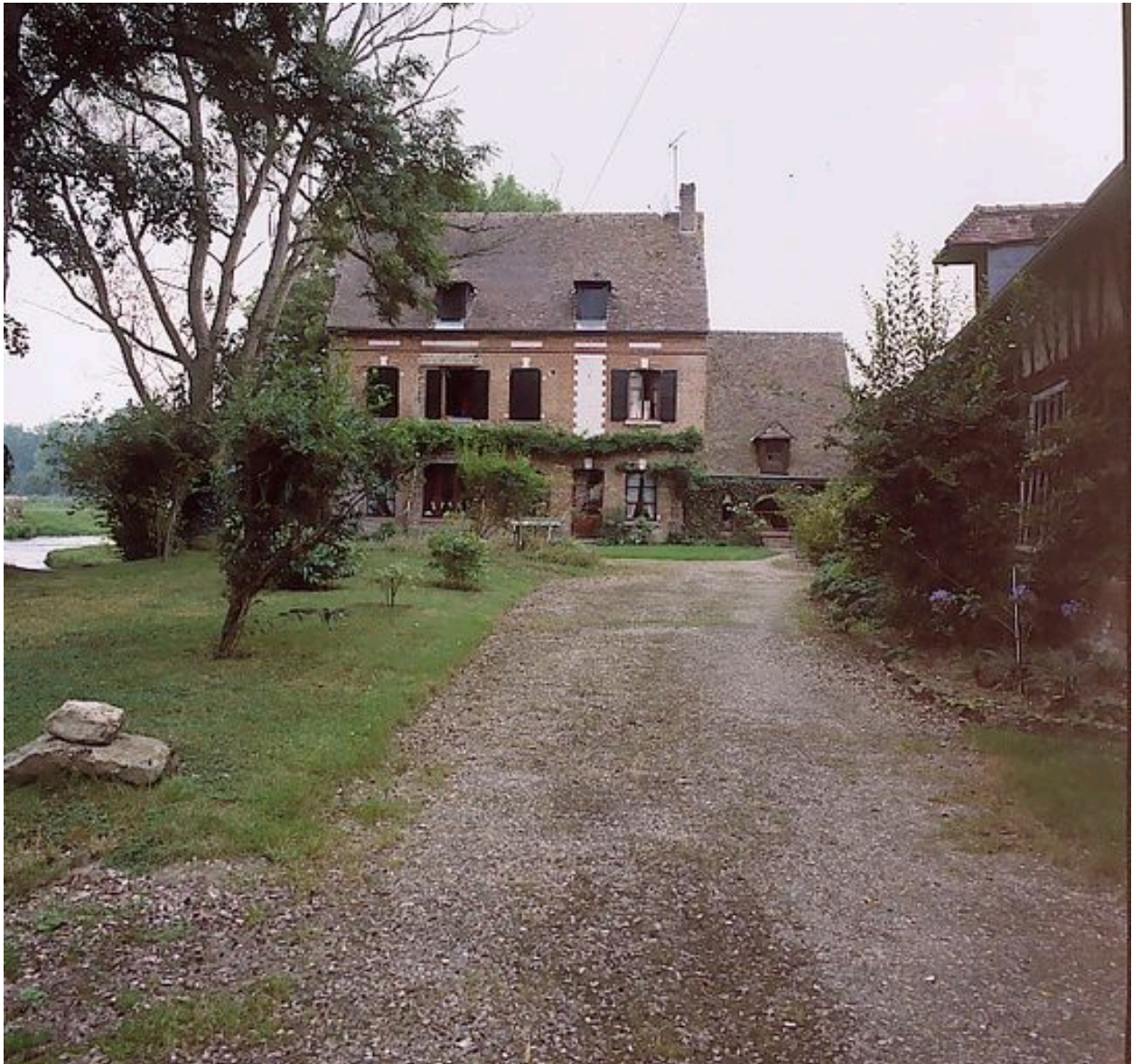
Vue générale de la façade sur cour.
