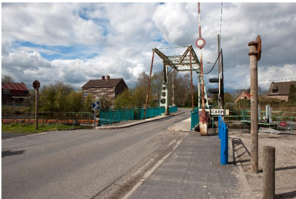
Le pont mobile sur la Scarpe.
