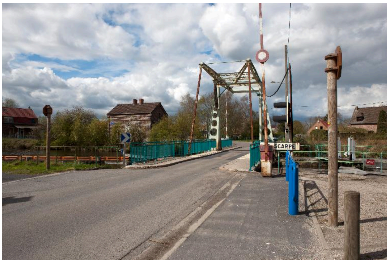
Le pont mobile sur la Scarpe.
