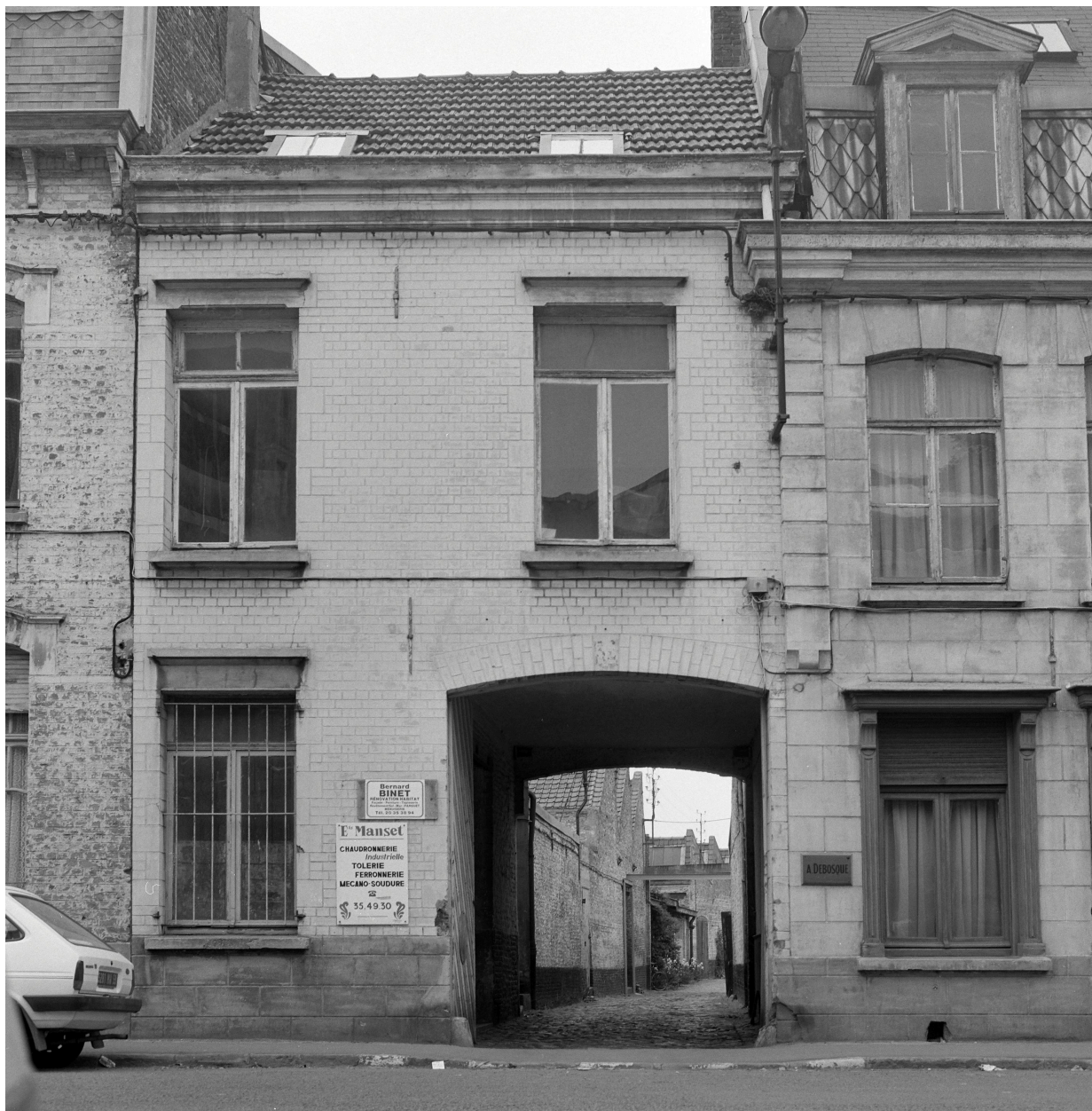
Élévation antérieure et passage couvert conduisant aux ateliers (cf. angle de prise de vue 2)
