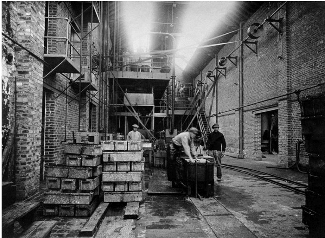
Atelier de fabrication : vue intérieure, vers 1950 (AP).
