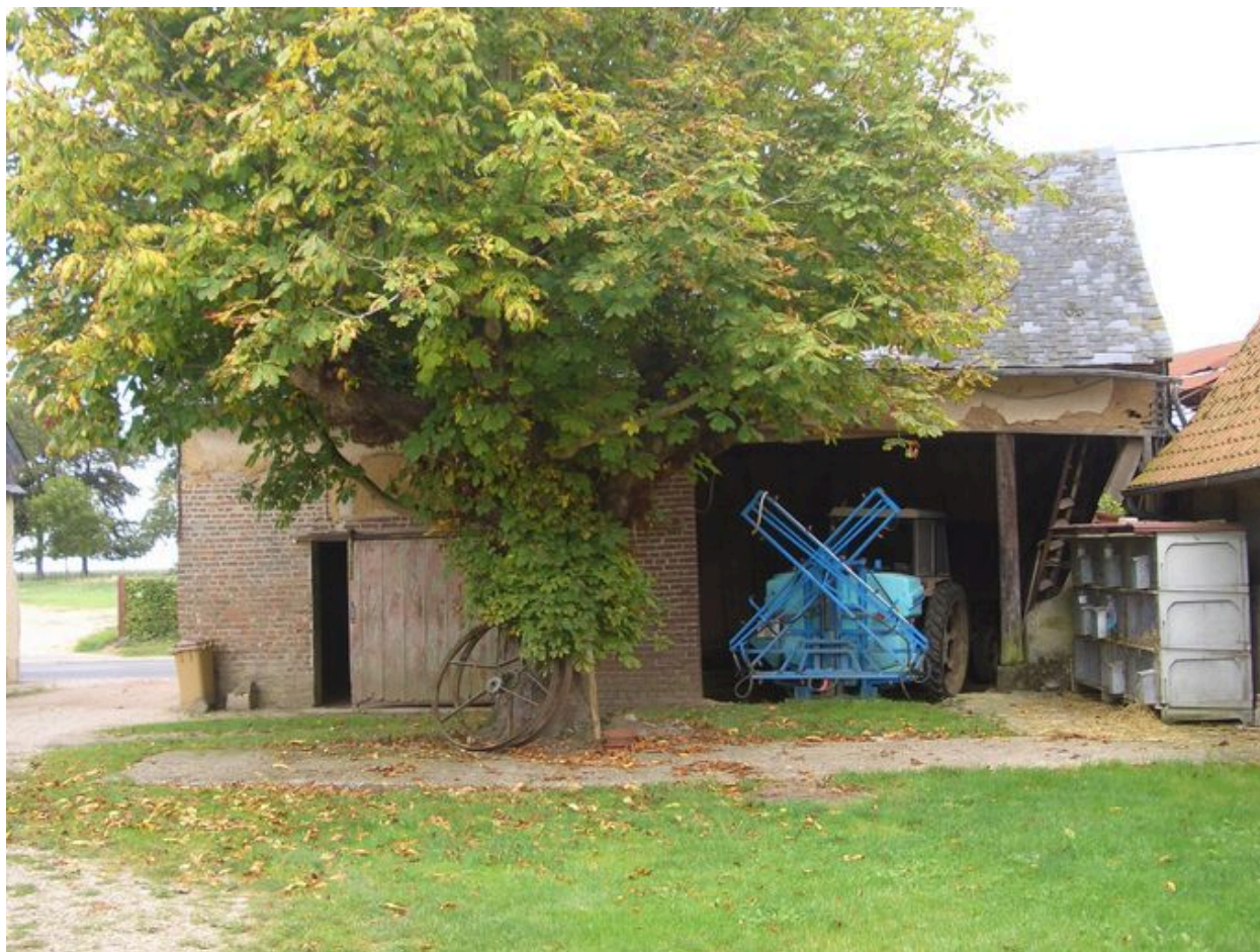
Vue postérieure de cette grange.
