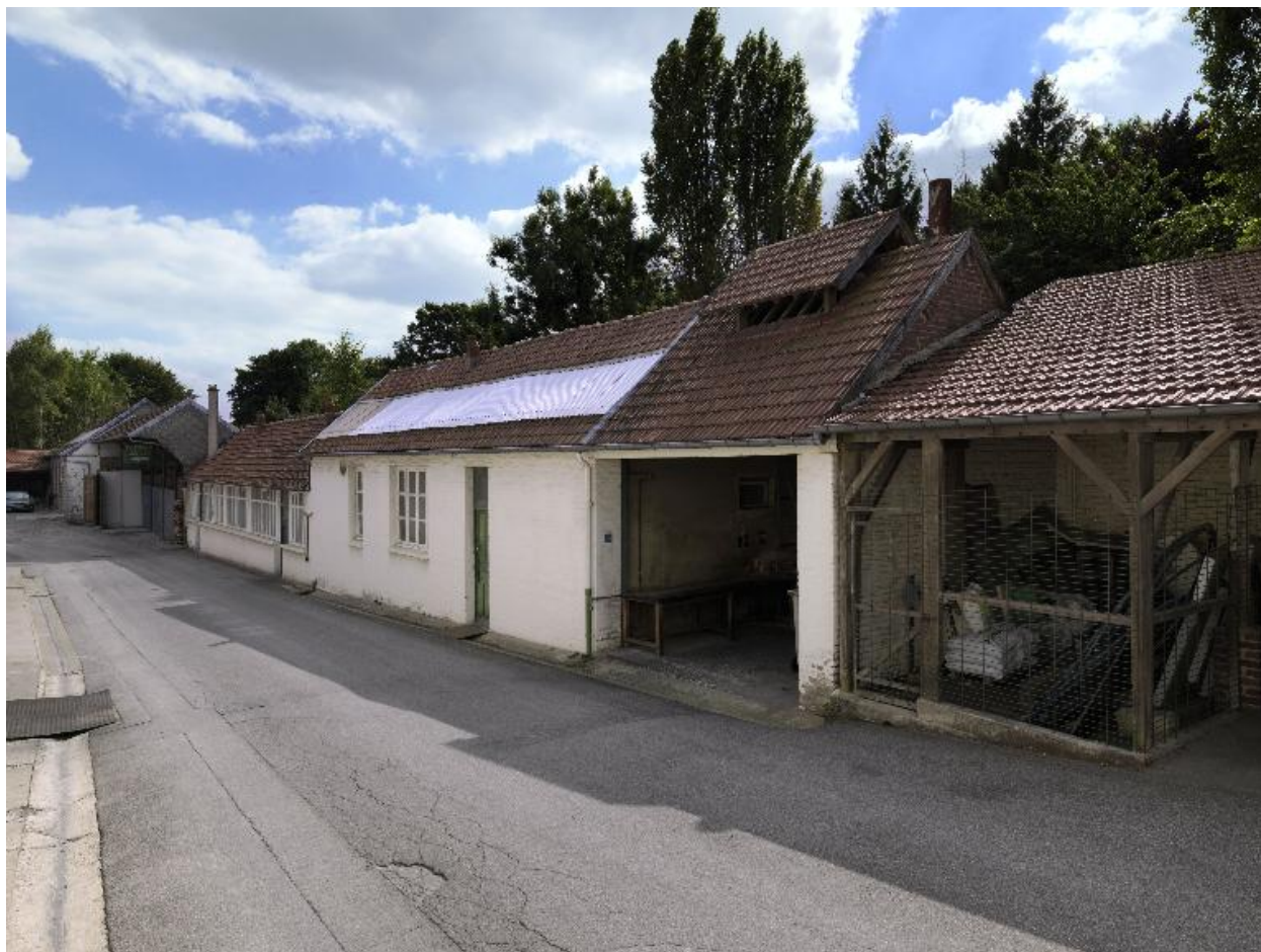
Vestiaires et anciens ateliers de fabrication.
