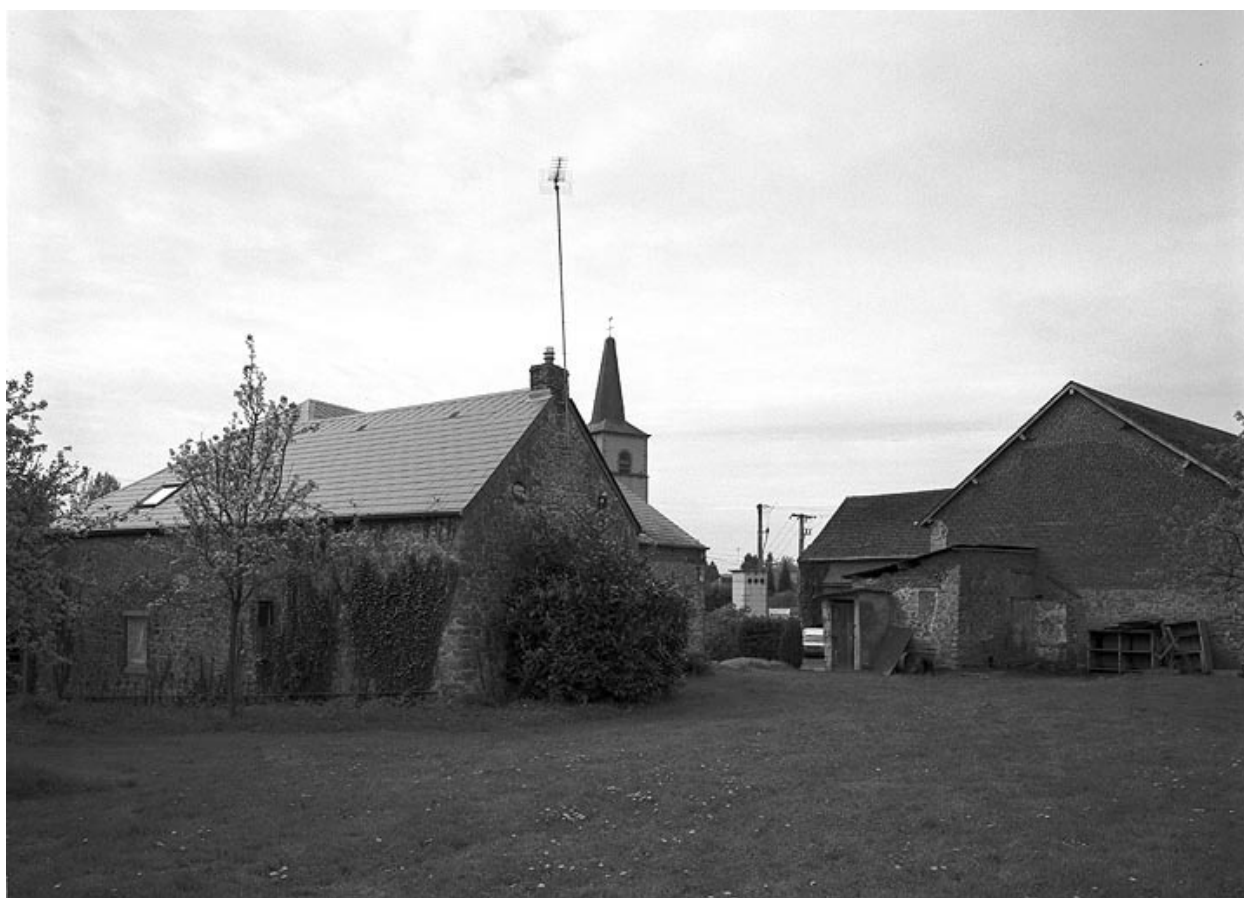
Vue de l'élévation postérieure du logis.
