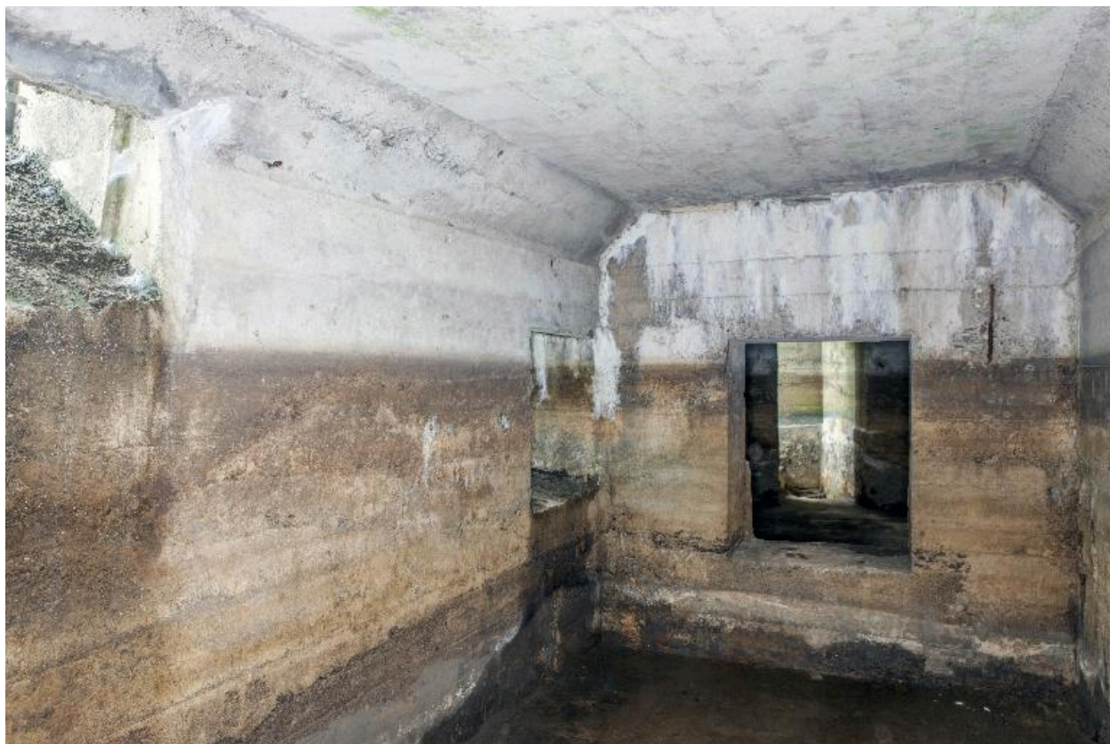
Vue intérieur de l'abri vers l'entrée ouest
