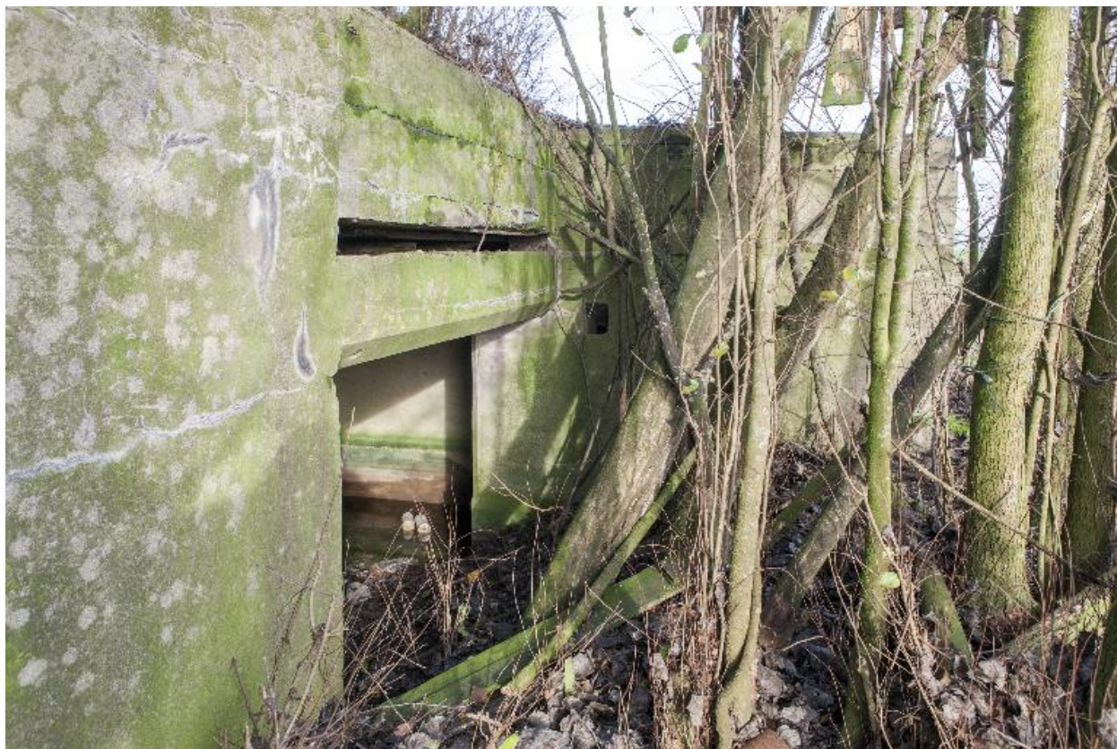
Elévation sud-est. L'entrée de la chambre de tir et le double couvrement avec sa cellule d'éclatement
