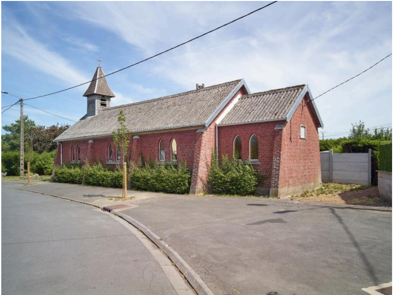
Vue de trois-quarts arrières vers le nord-est.
