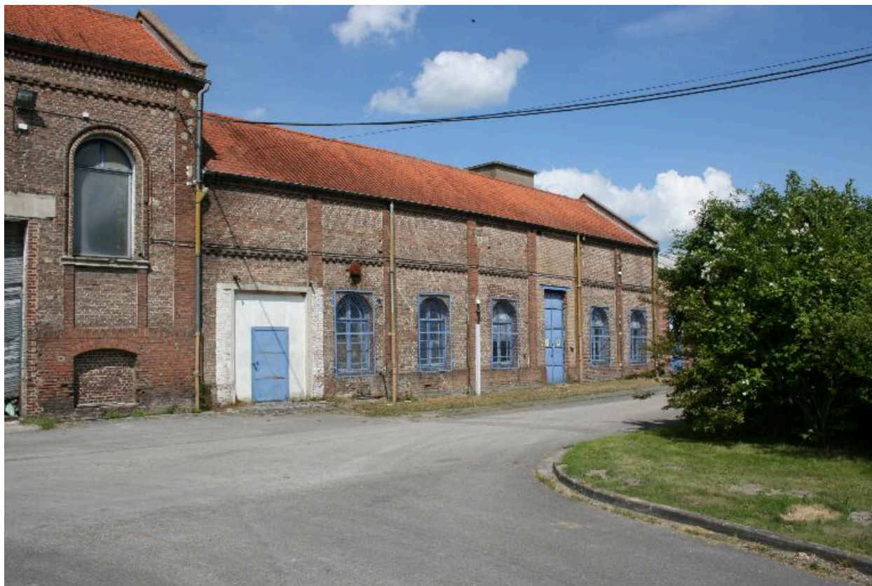
Façade sud du magasin à fil.
