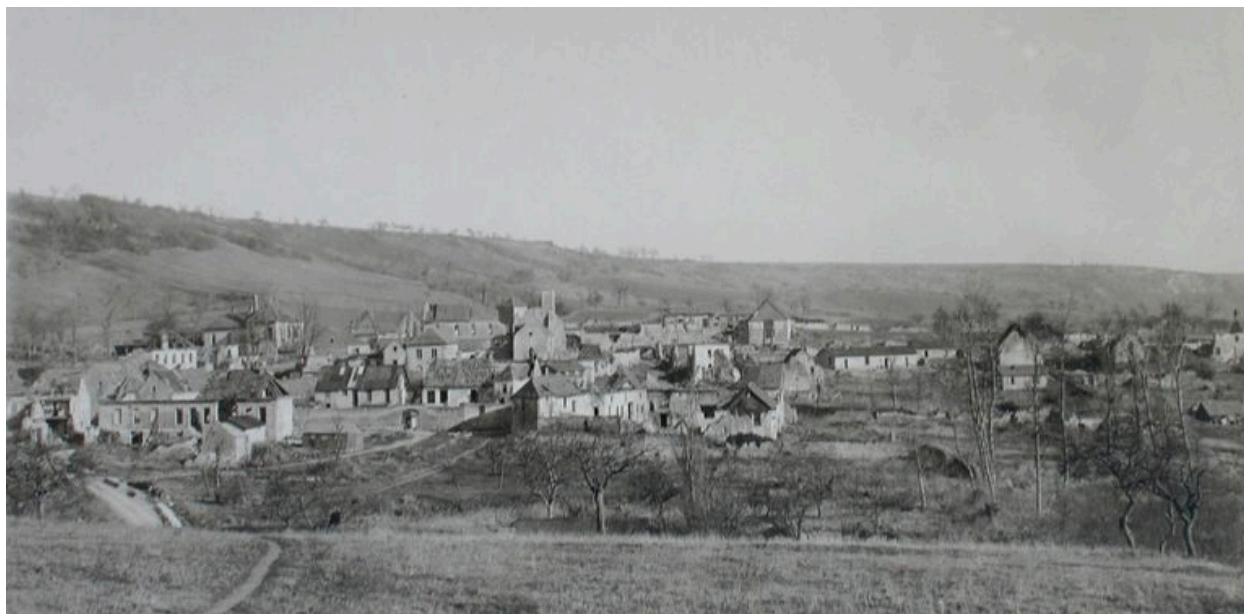
Panorama ancien du village (AD Aisne : 2 Fi Jumigny 1).
