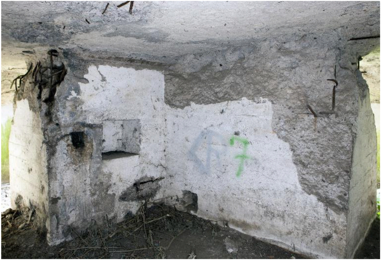
Couloirs en chicane de l'entrée est, à gauche et ouest à droite
