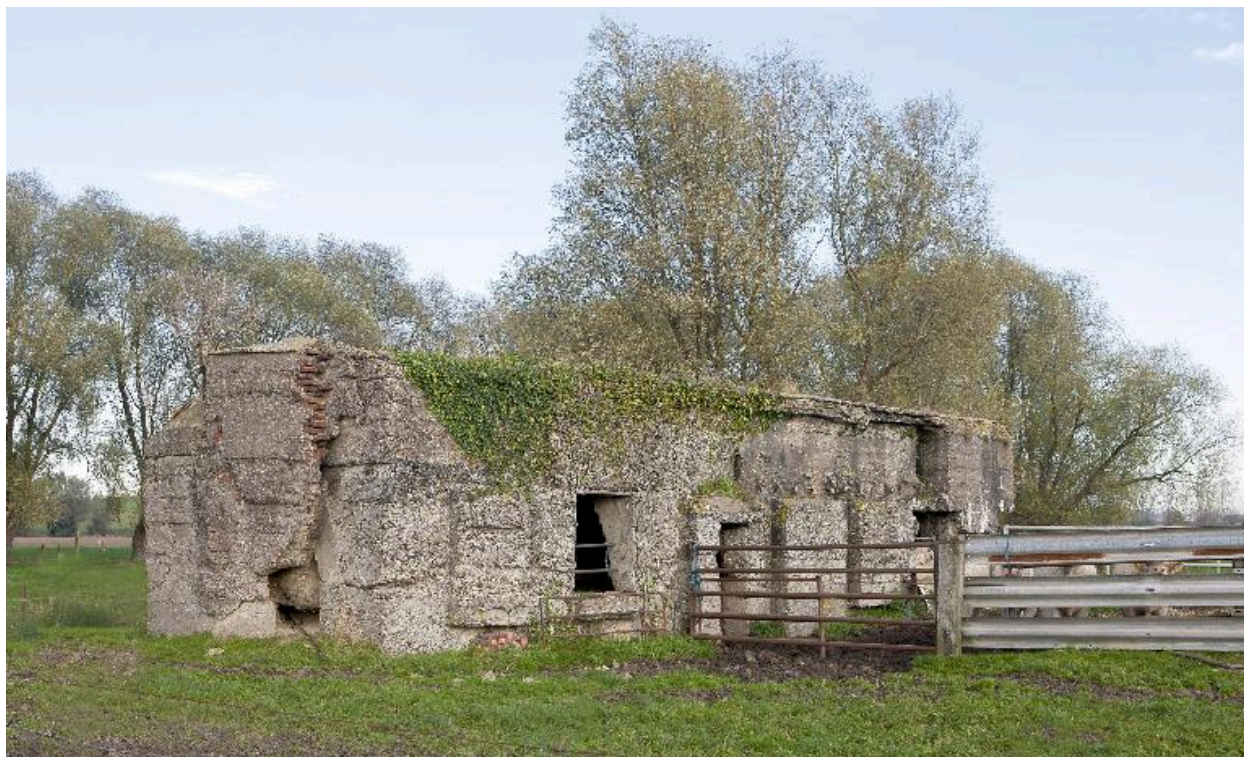
Vue de trois-quarts vers le nord-est
