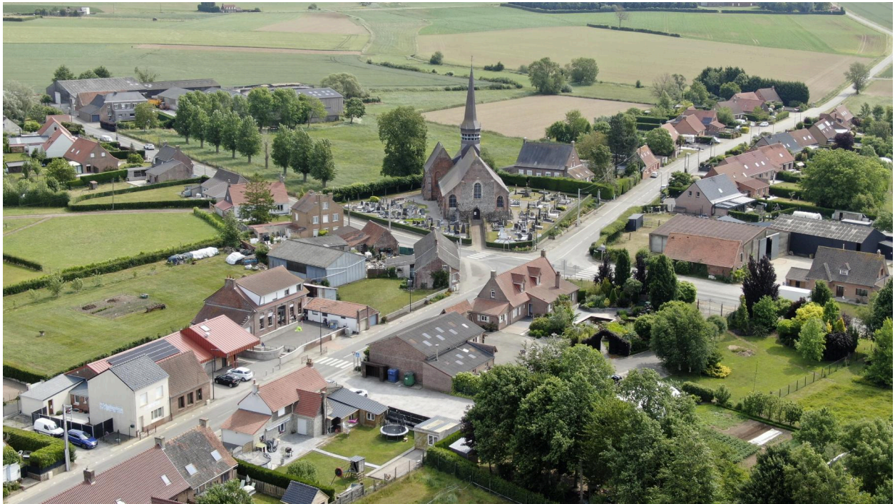
Vue aérienne du centre bourg.
