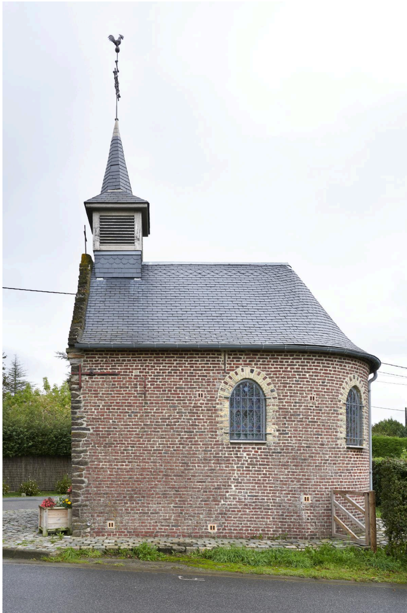
Flanc ouest de la chapelle.
