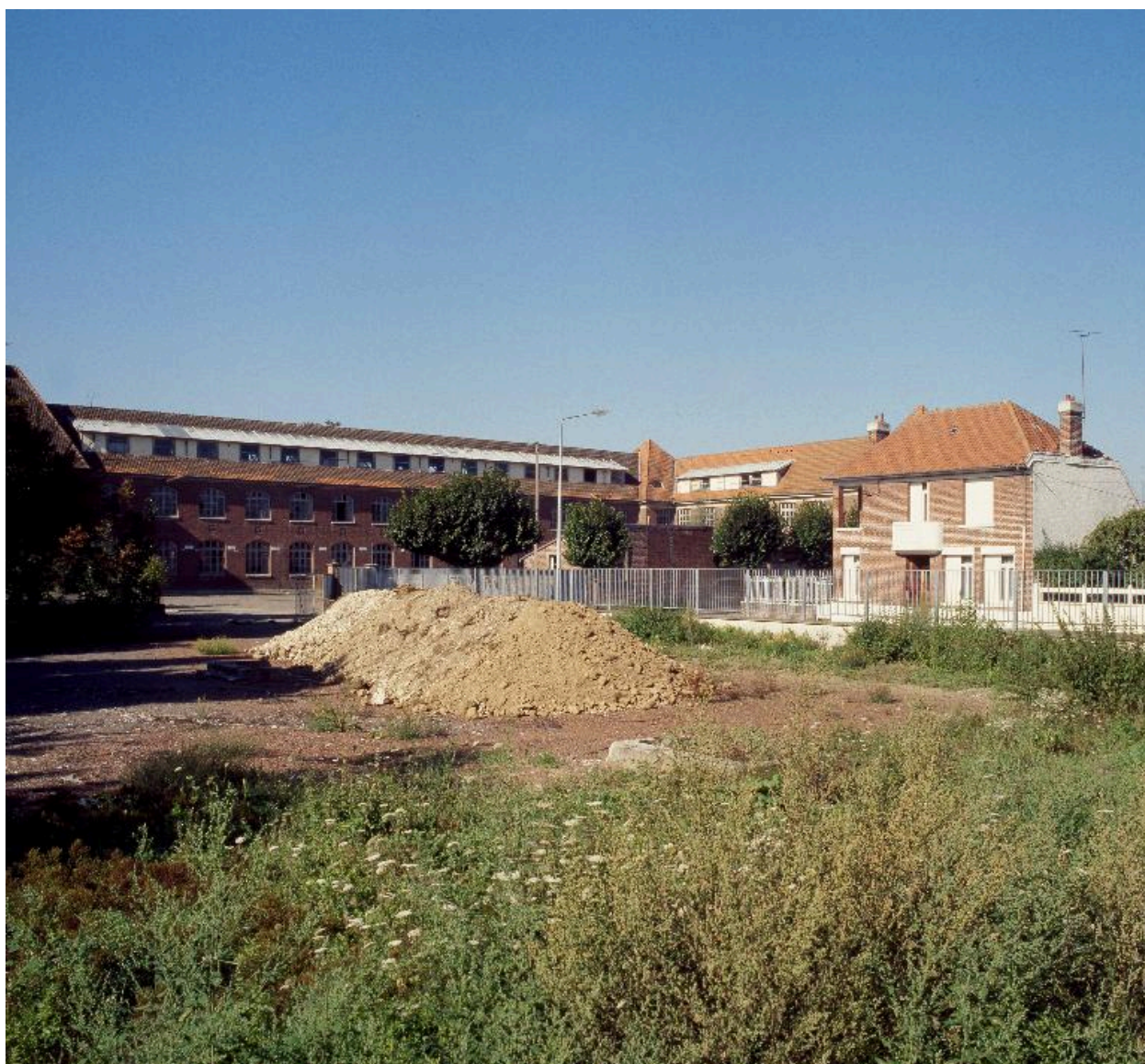
Vue de la façade depuis la rue Edmond-Carré, vers la rue Victor-Hugo.
