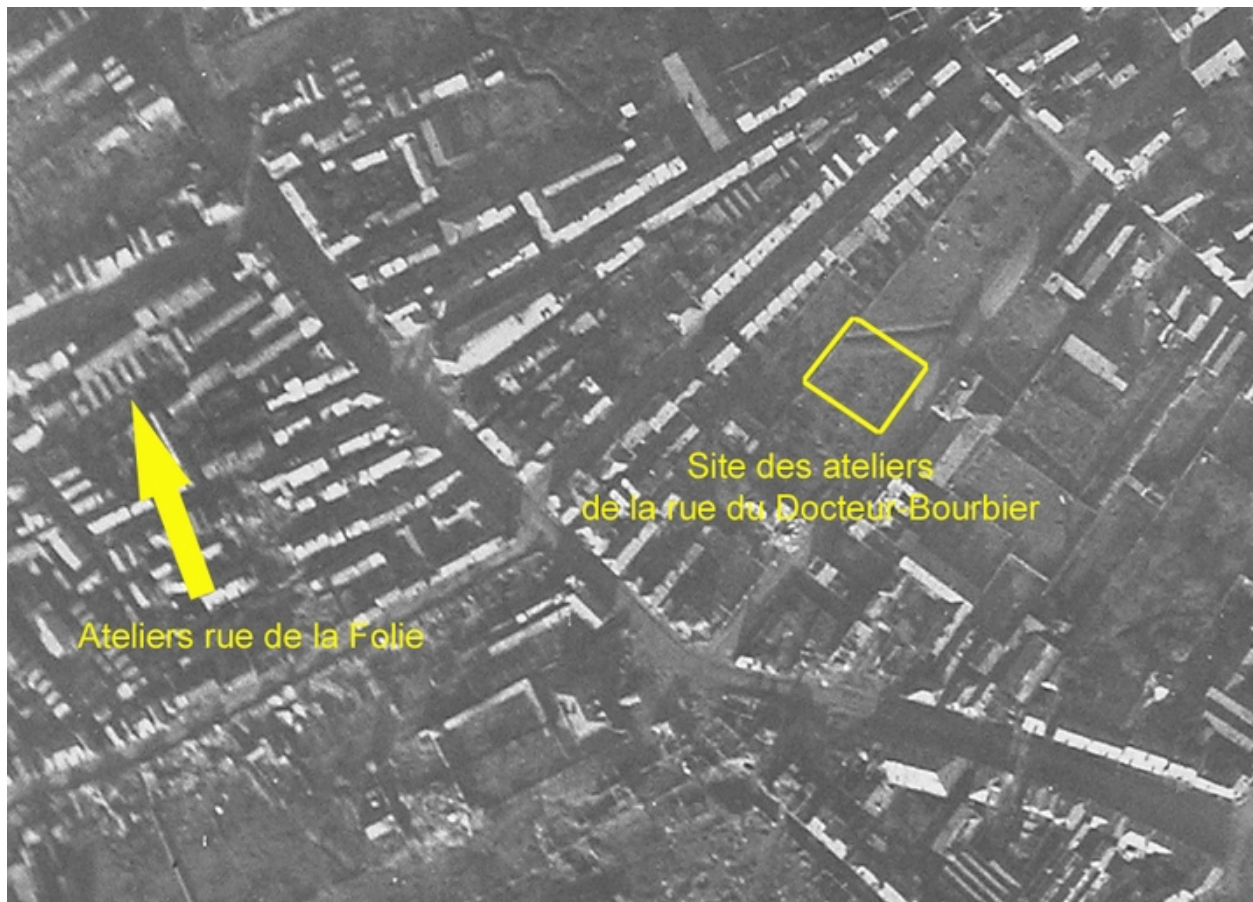
Vue aérienne du site avant construction, novembre 1918 (AD Aisne).
