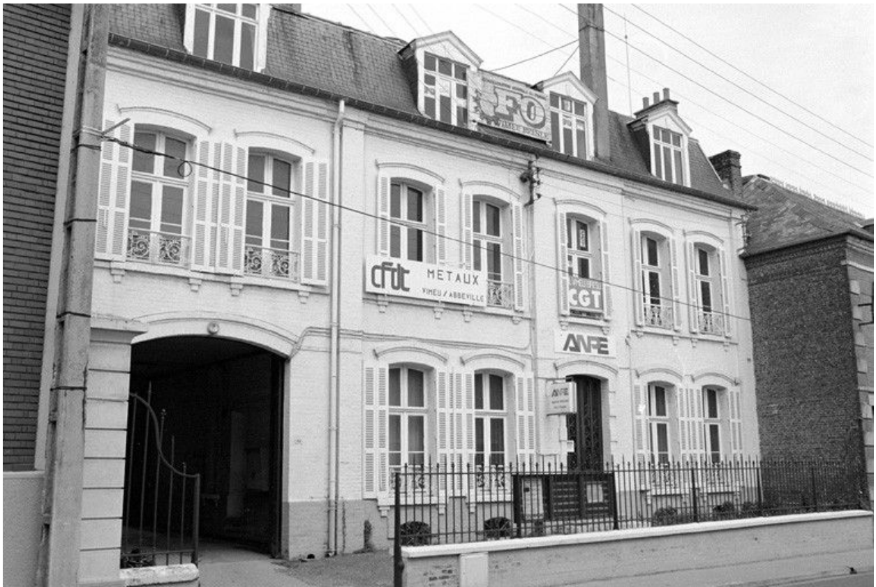
Logement patronal n°1, élévation antérieure, en 1990.
