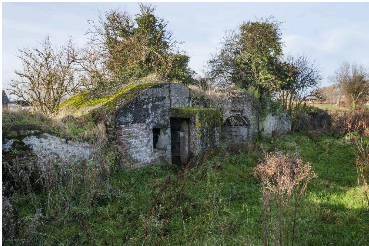
Casemates b, c, d, e et f, en enfilade vers le nord.
