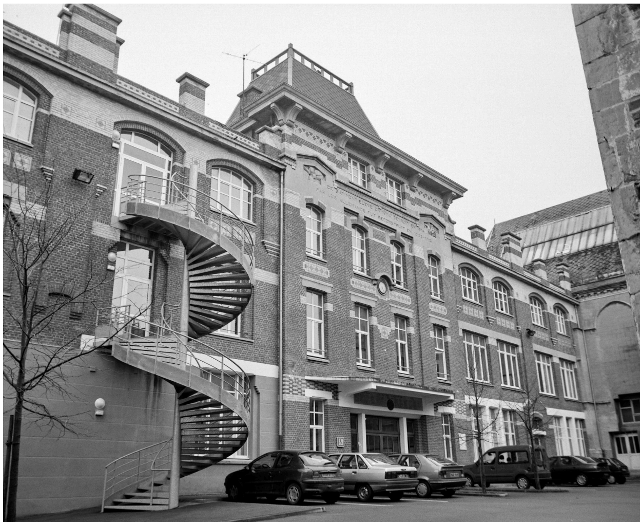
Vue de l'aile occidentale, reconstruite en 1922 par l'architecte Jean Lafitte (1853-1928).
