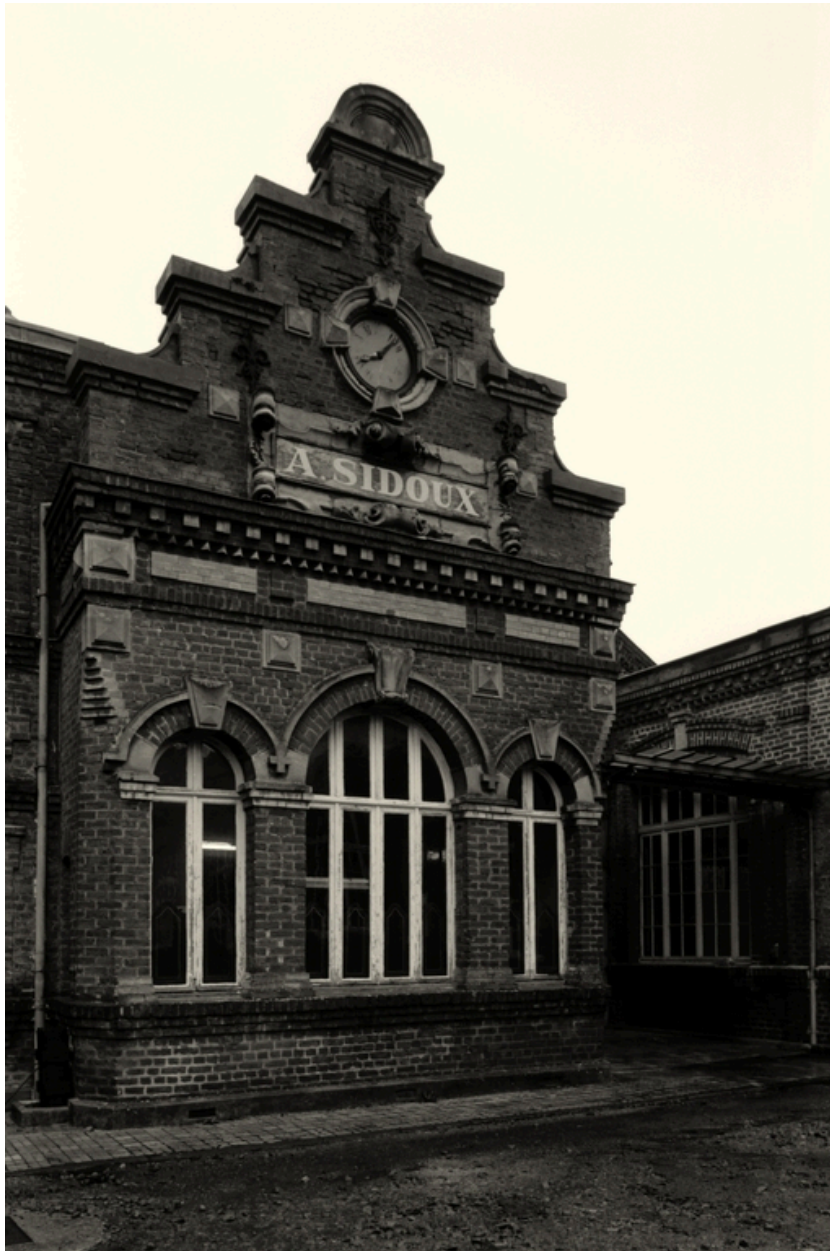
Ancien bureau, détail du pignon à pas de moineau et de l'horloge, 1988
