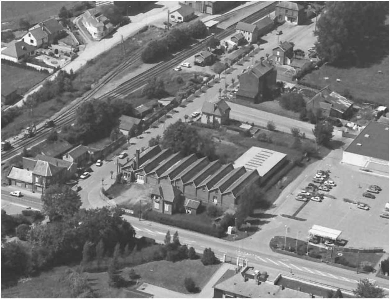
Vue aérienne de l'usine en 1994.
