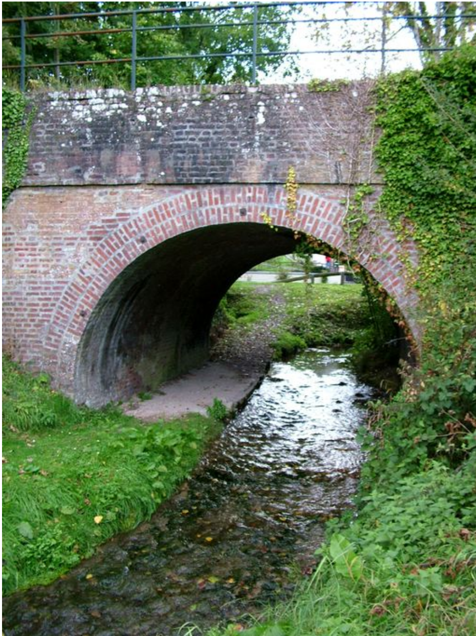
Le pont ferroviaire franchissant la Fieffes au lieu-dit les Chanvrières de Rhin.
